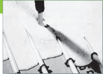
Schon beim Gießen ist es offensichtlich: Durch seine fließfähige Konsistenz umschließt der Fließestrich die Heizleitungen vollständig und homogen – ganz ohne Hohlräume.
